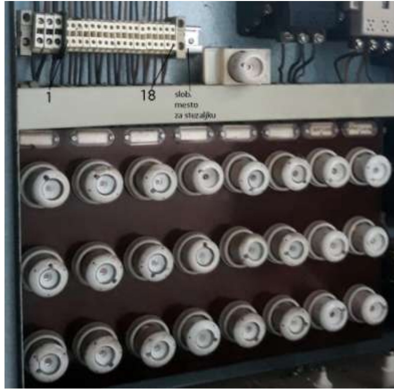
Слика 3: Изглед постојећег РО са могућношћу доградње за напајање нове ТП1
